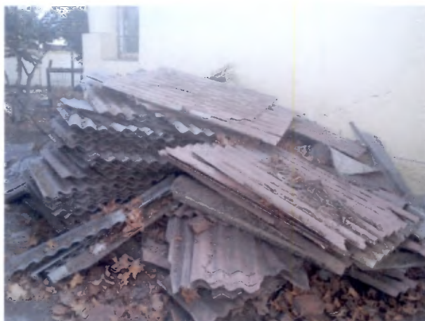
Techumbre como escombros sin retirar
