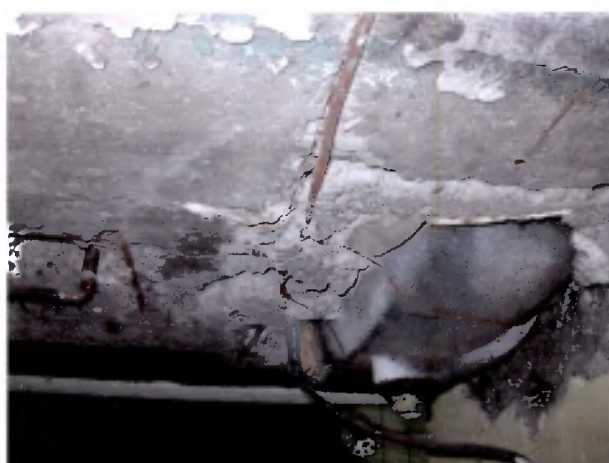
Lavamanos sin desagüe
