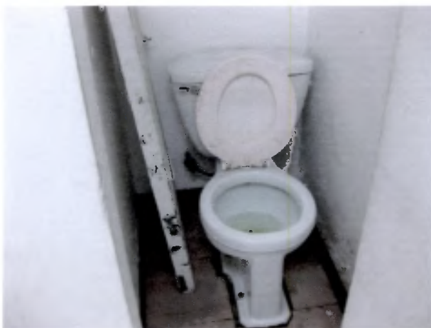
Baño sin puerta
