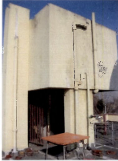
Copa de agua del edificio
