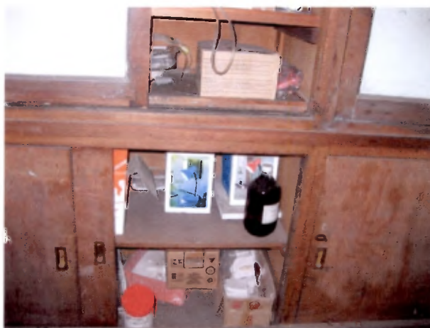
Falta de orden, aseo y resguardo de los insumos; mobiliario inadecuado y en mal estado
