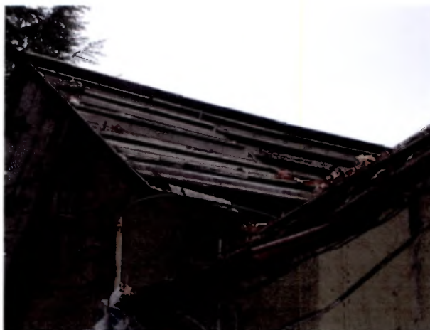
Daño en la techumbre
