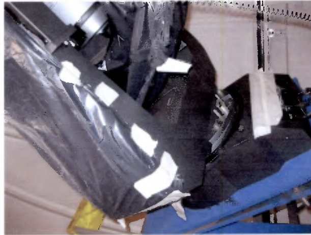
Telescopio cubierto con bosas para protegerlo de las filtraciones
